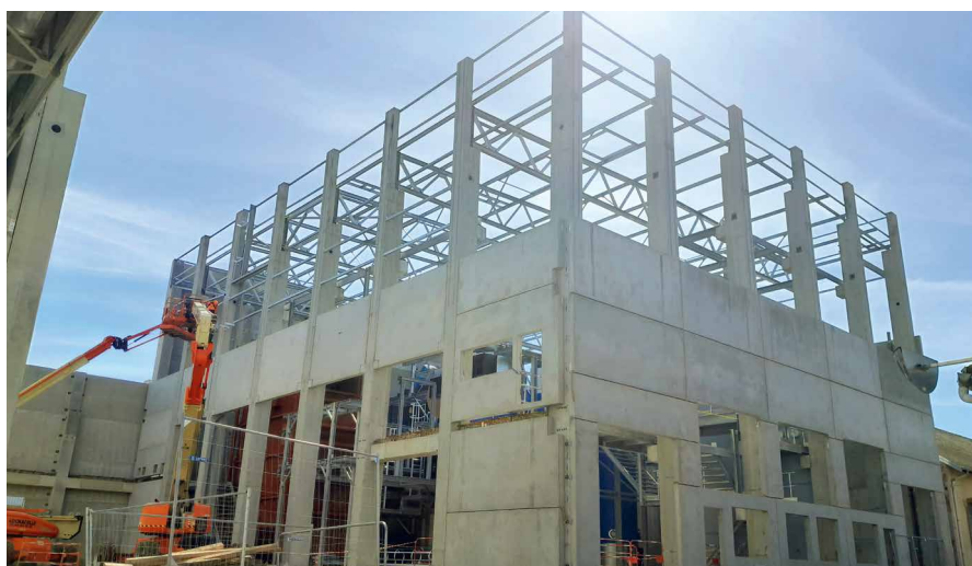
Papeteries de Clairefontaine – Chaudière biomasse en cours de construction
